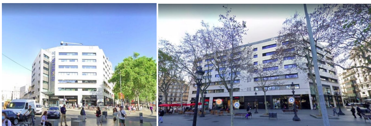
Figura 4. Imágenes exteriores del edificio
